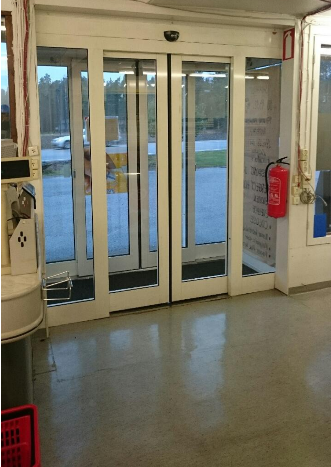
Automaattiset kulkuovet asiakkaiden sisäänkäynnissä
